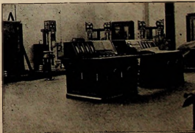
Fig. 3. Schakellessenaar. Op den achtergrond de lamphouders.
